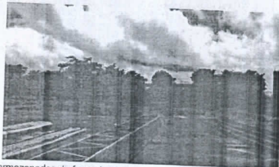
Foto 16 e 17 – Arcos metálicos armazenados de forma irregular
