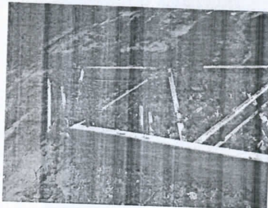
Foto 18 e 19 – Peças metálicas apresentando corrosão e perda de seção
