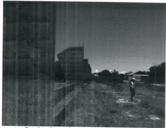
Foto 04 – Pilares Desalinados
